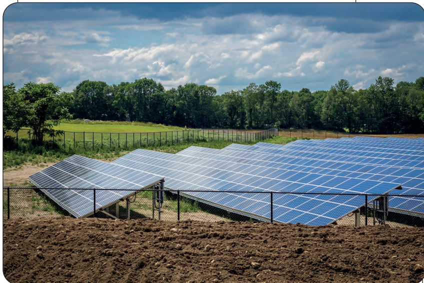
Figure 8.5. Installation de panneaux solaires au sol dans le cadre d'un projet d'agrivoltaïsme.
