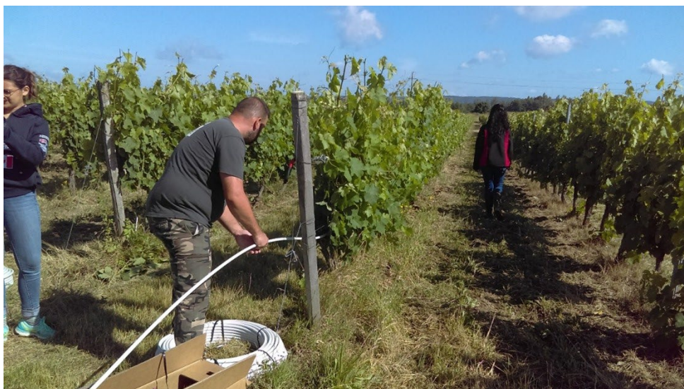
Photo 3 : Installation du matériel Nétafim pour la pulvérisation fixe.
