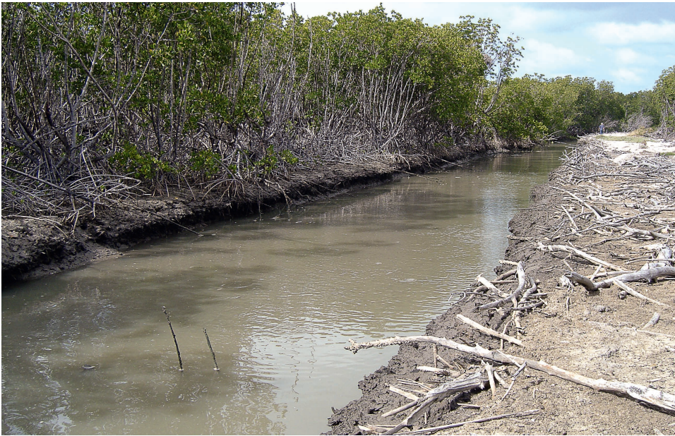
Figure 3.2. Canal creusé dans la mangrove pour évacuer les effluents sur le site d'une ferme de crevette en Nouvelle-Calédonie.
