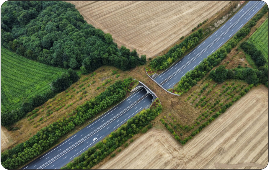
Figure 2.3. Passage à faune (Montauban de Bretagne, Ille-et-Vilaine).
