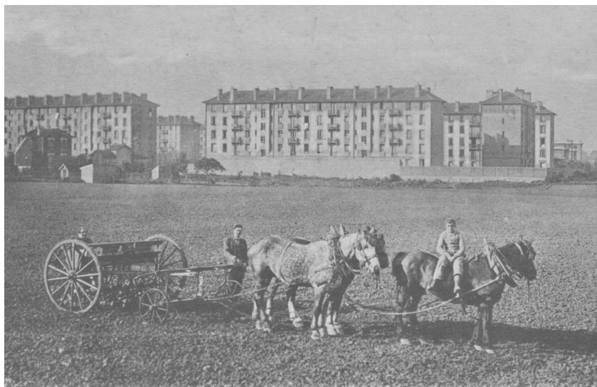
Figure 24. Quartier de la Saussaie-Pidoux, Villeneuve-Saint-Georges, vers 1930-1940.
