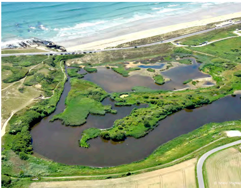
Photo 1 – Étang du petit Loch et ouvrage de sortie en mer. Crédit photographique : Marc Rapillard.
