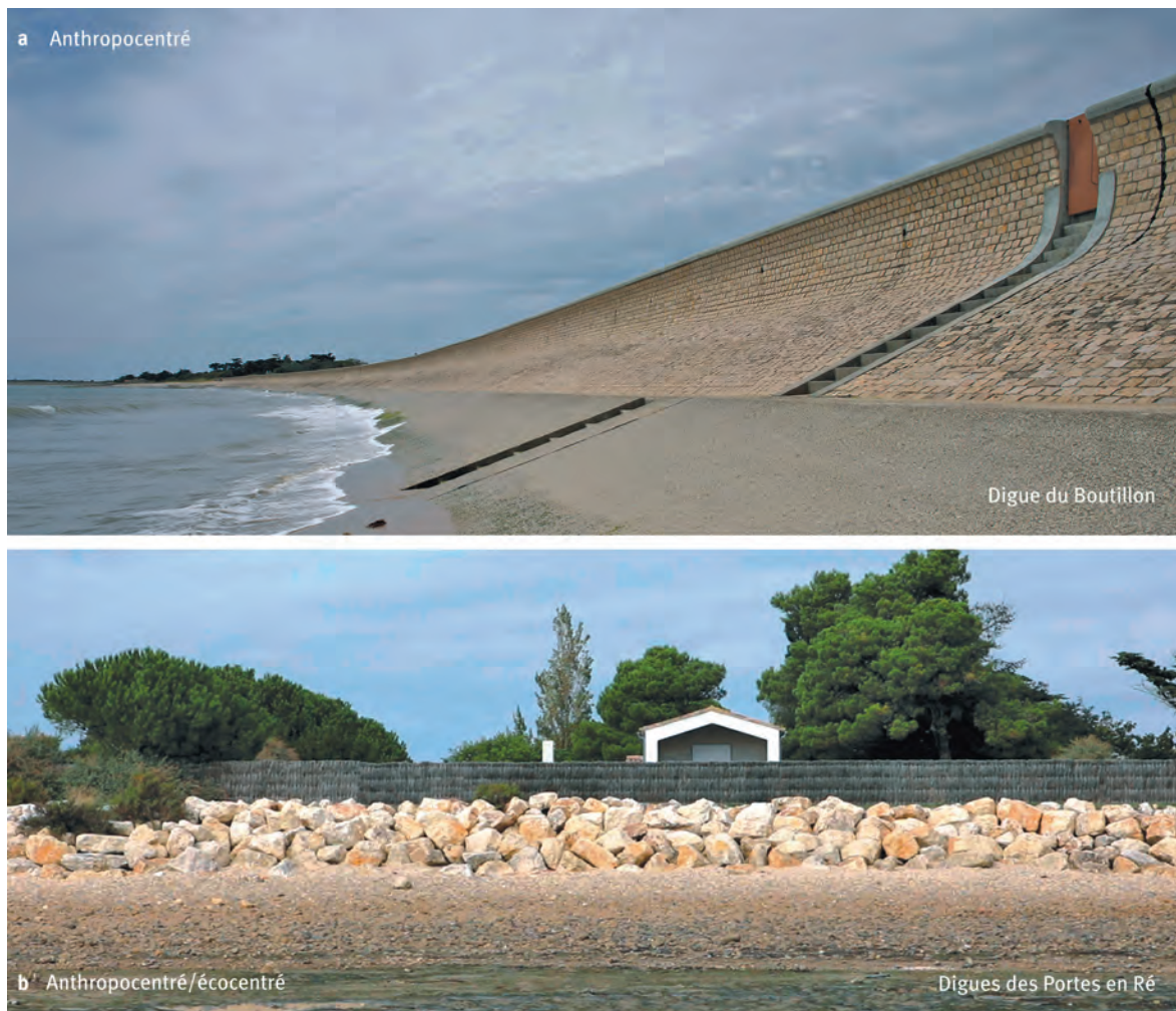
Photo 1a et 1b – Exemple de digues « anthropocentrée » et « écocentrée ». Crédit photo : Olivier Cruzel.
