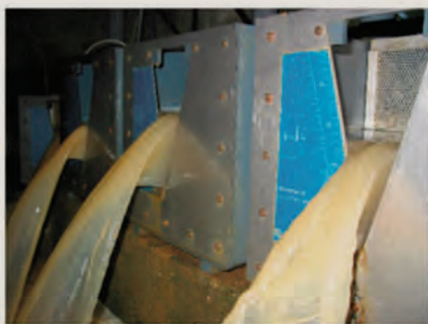
1 Bacs déversoirs pour la mesure du débit d'eau.
