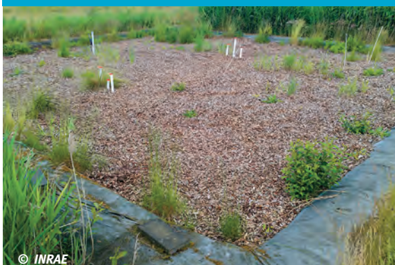
1 Exemple d'un bioréacteur rempli de copeaux de bois (Skannerup, Danemark).
