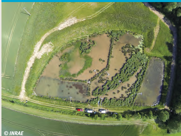
8 Photo aérienne de la zone tampon humide artificielle de Rampillon (Seine et Marne).
