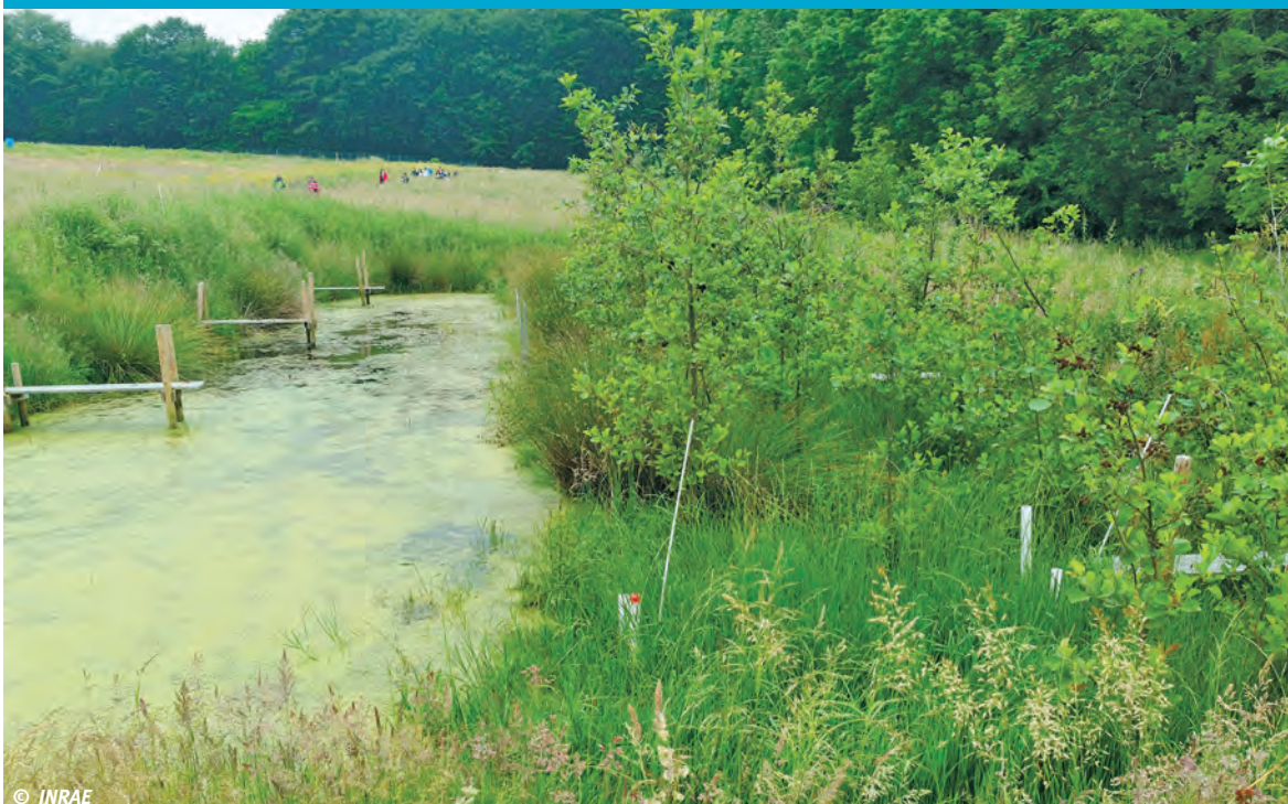
4 Exemple d'une « integrated buffer zone » avec en amont un bassin hydraulique et un écoulement dans la zone riparienne restaurée, connecté au cours d'eau (Fillerup, Danemark).
