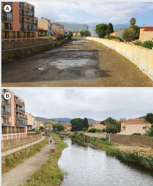
Figure 2.10. Exemple de restauration d'un secteur intermittent de la Baillaury (Pyrénées-Orientales).
