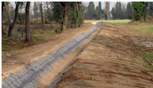
Photo 6.4. Afin d'améliorer les performances du système, le canal peut-être maçonné (a) ou recouvert d'une membrane (b), culture de foin de Crau, France (© F. Charron).
