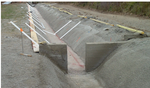
Photo 6.4. Afin d'améliorer les performances du système, le canal peut-être maçonné (a) ou recouvert d'une membrane (b), culture de foin de Crau, France (© F. Charron).
