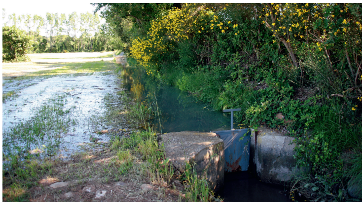
Photo 6.3. Irrigation d'une parcelle de foin de Crau par submersion à l'aide d'un canal en terre et d'une martelière (© F. Charron).
