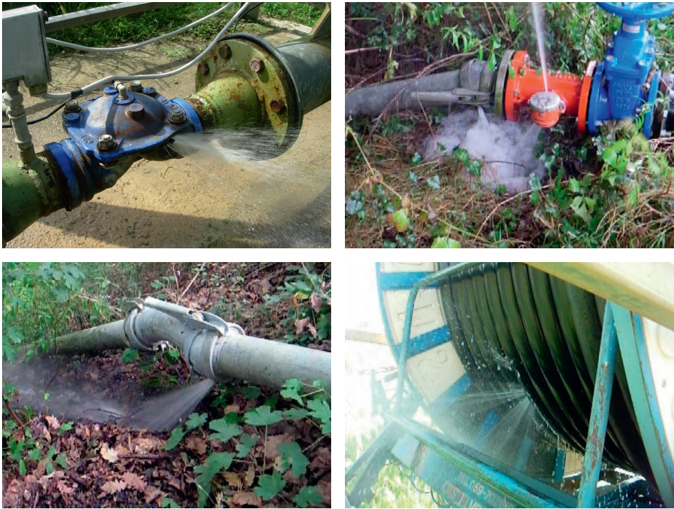
Photo 7.1. Les fuites dans les équipements d'irrigation à la parcelle sont à l'origine d'une baisse d'efficacité de l'irrigation (© J. Granier).
