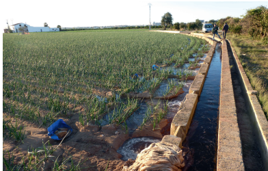
Photo 6.7. Canal maçonné avec vannettes de distribution de l'eau, la pierre en aval de la vannette permet de réduire l'érosion, cultures oignons et maraîchage, Espagne (© F. Rossel).
