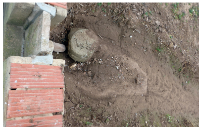
Photo 6.7. Canal maçonné avec vannettes de distribution de l'eau, la pierre en aval de la vannette permet de réduire l'érosion, cultures oignons et maraîchage, Espagne (© F. Rossel).
