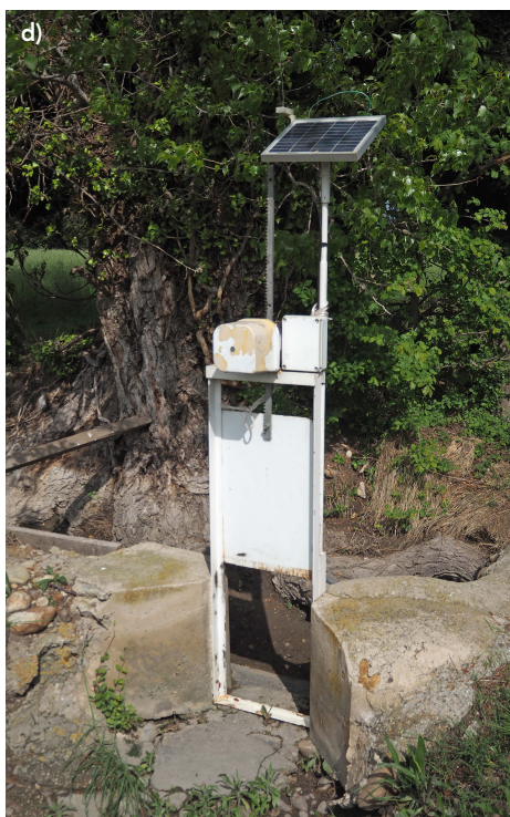
Photo 6.5. Exemples d'automatisation de martelière dans la plaine de la Crau : culture de foin de Crau, France (a, b et d : © M. Moebs ; c et e : © F. Charron).
