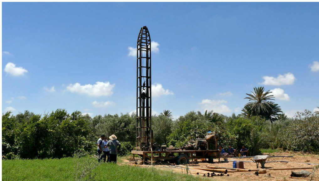
Photo 3.8. Installation d'un groupe de pompage dans un forage (© C. Leduc).
