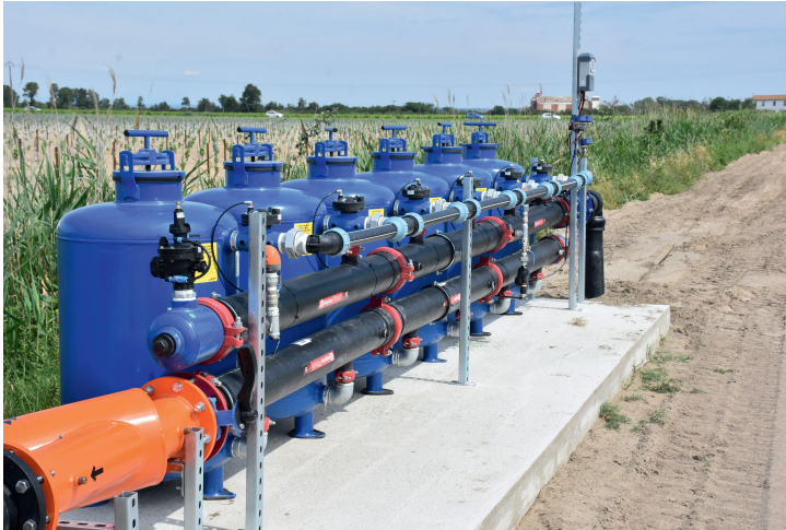
Photo 5.1. Station de filtration (© BRLE).
