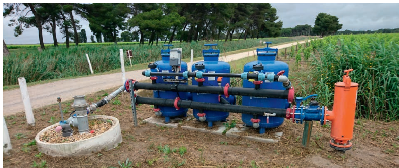
Photo 5.15. Poste de filtration combinant trois filtres à sable et un filtre à tamis (© INRAE/B. Molle).
