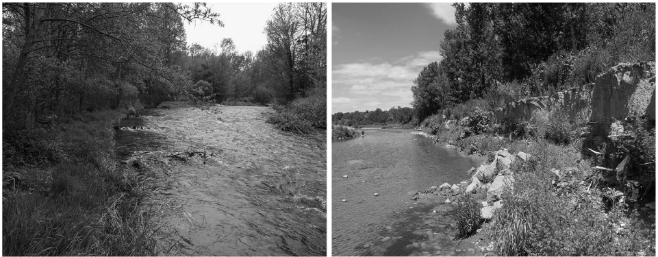
Figure 11.1. Illustration de l'ambivalence de la restauration des milieux riverains : à gauche, berge protégée par du génie végétal douze ans après la fin du chantier ; à droite, berge érodée suite à la suppression d'enrochements (© INRAE).
