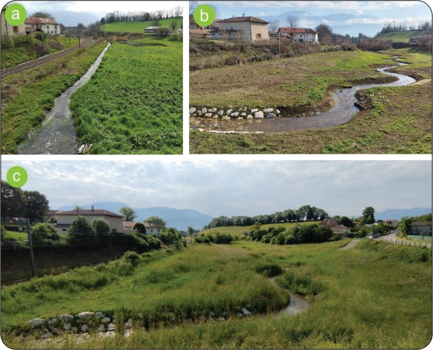
**Figure 2.8.** Contournement de seuil sur le Guiers, en Savoie. La pente du cours d'eau, adoucie, permet aux poissons de circuler de part et d'autre du seuil.
