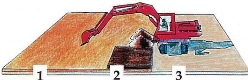
4 – Régalage de la couche supérieure par une pelle montée sur pneus, depuis le soubassement de la bande 3. Travail en poussée et en rétro, avec nécessité de pivoter la tourelle pour reprendre en rétro la terre versée sur le soubassement.
