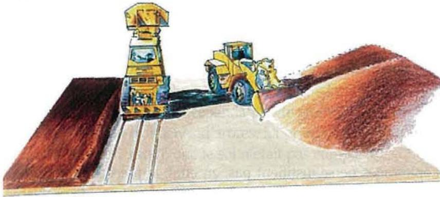
1 – Rippage du soubassement (trax, boteur, chargeur en rétro).
