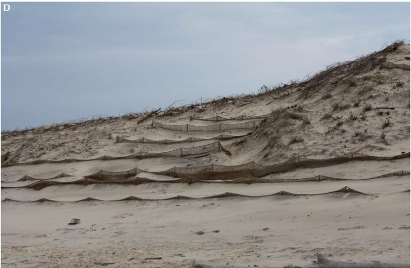
**Figure 3.21.** Exemples de brise-vent en fibre de coco.
