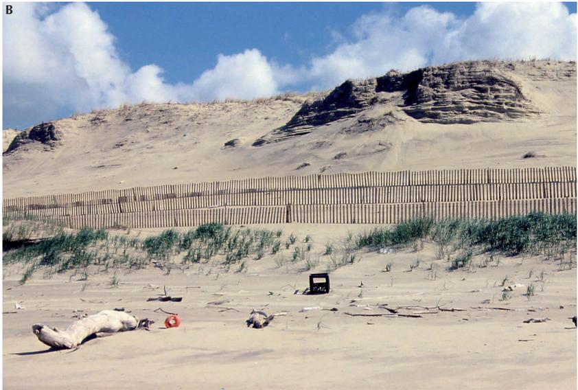
**Figure 3.4.** Exemples de travaux d'aide à la formation d'avant-dunes (Médoc/Gironde).
