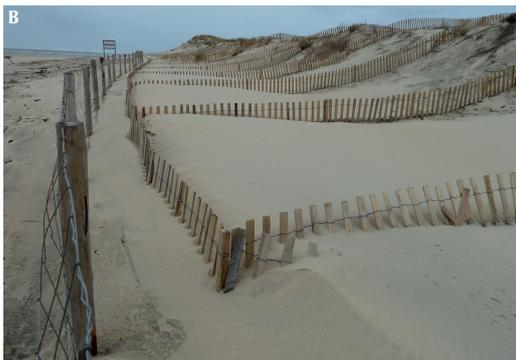
**Figure 3.19.** Brise-vent utilisés en zone frontale pour recharger le profil dunaire.
