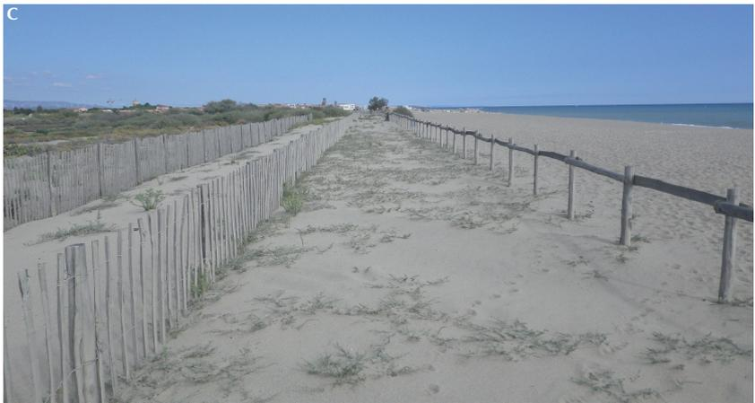
**Figure 3.5.** Exemples de restauration de cordon dunaire par actions de contrôle souple, dans les Pyrénées-Orientales à Canet-en-Roussillon et à Toreilles.
