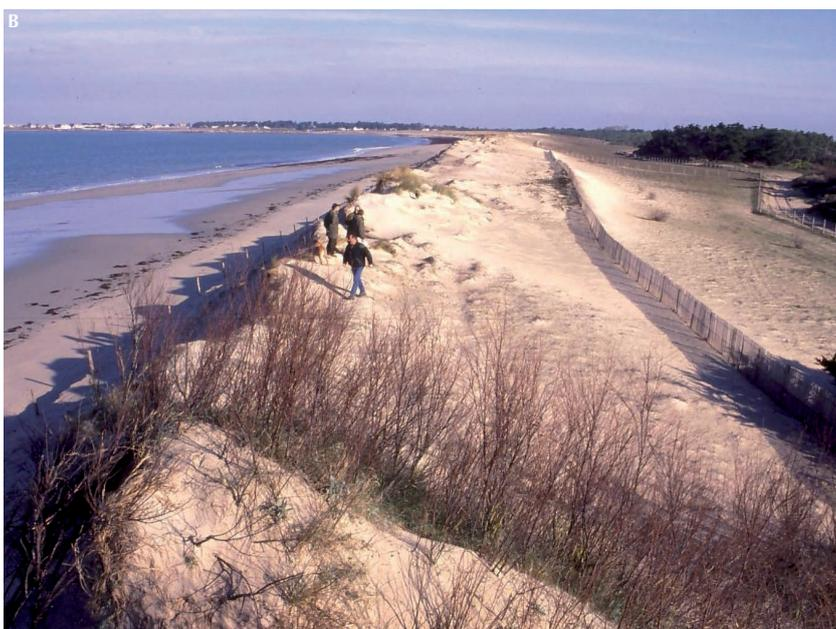
**Figure 3.6.** Exemple de travaux de contrôle renforcé de la dune de Luzéronde (côte nord-ouest de l'île de Noirmoutier) qui joue un rôle de protection contre les risques de submersion.
