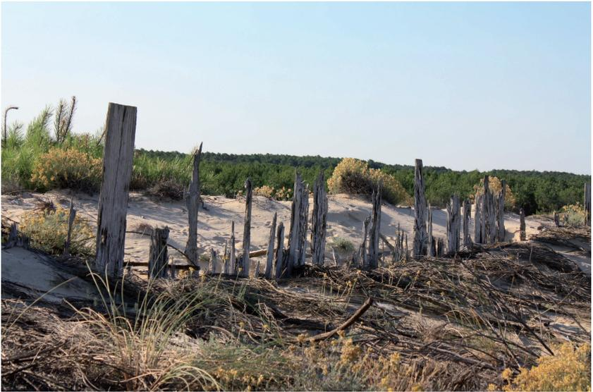
**Figure 3.14.** Vestiges d'une ancienne palissade destinée à piéger le sable.
