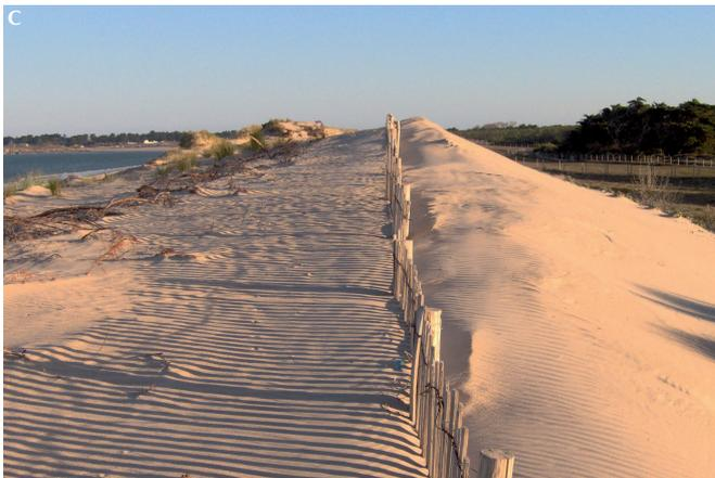
**Figure 3.20.** Brise-vent en ganivelles utilisés hors de la zone frontale pour limiter l'étalement du sable en arrière-dune et/ou pour maintenir la continuité longitudinale du cordon.
