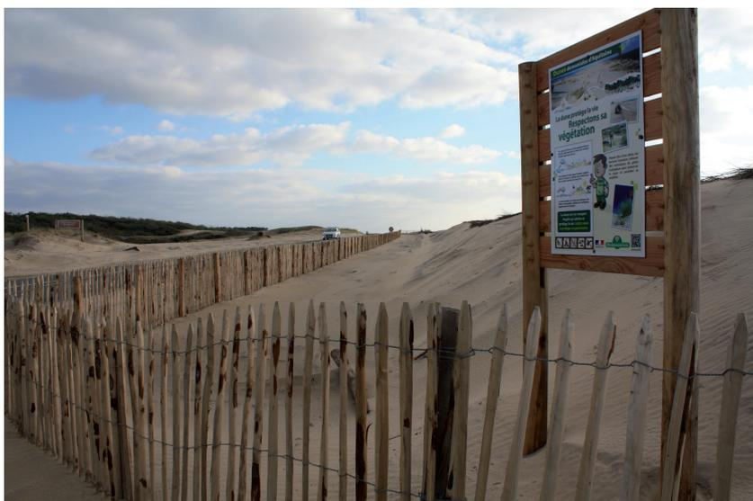
**Figure 3.36.** Ganivelles servant à canaliser le public et panneau d'information (Montalivet).
