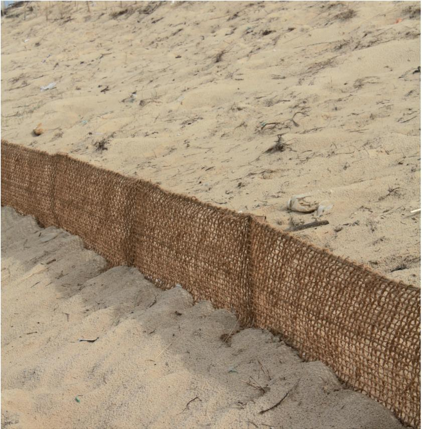
**Figure 3.16.** Filet en fibre de coco.
