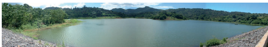
Figure 4.22. Retenue collinaire de Dzoumogné (© Bouvy, IRD).
